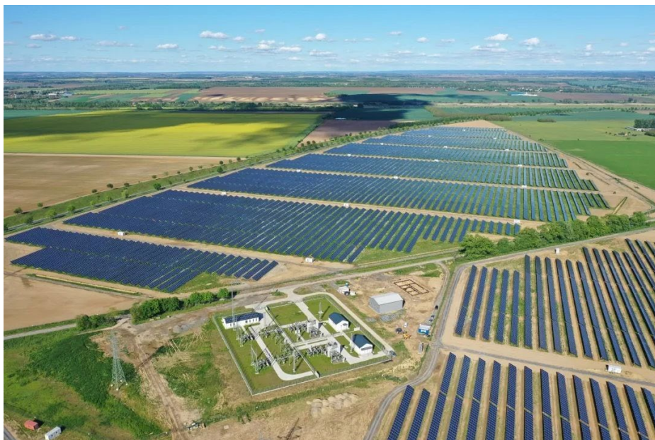
建成后的电站俯瞰图，来自中国通用技术集团澎湃号
